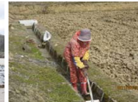
トラフ(水路)の掃除
