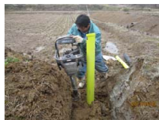
以前、転作をしていた水田に暗渠排水用の水甲栓を復元する作業(5月3日)
