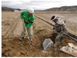
水田用排水柵(商品名「落口姫」)の設置作業(5月3日)
