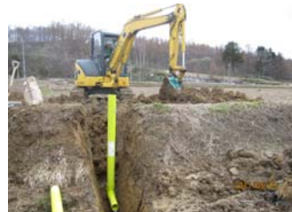
以前、転作をしていた水田に暗渠排水用の水甲栓を復元する作業(5月3日)
