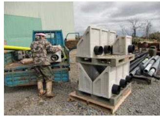
水田用排水柵(商品名「落口姫」)の設置作業(5月3日)
