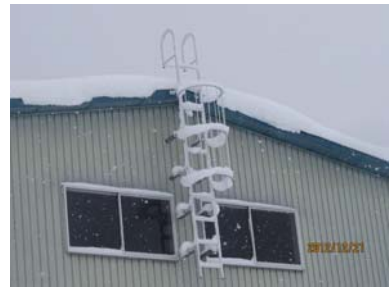
倉庫の屋根に安全梯子を設置(12月21日)
