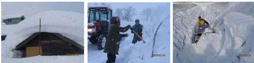
ポンプ小屋の状況(1月13日) ハウスの除雪～雪を崩す社長夫妻(中央)と除雪機を扱う山崎君(右)(1月14日)
