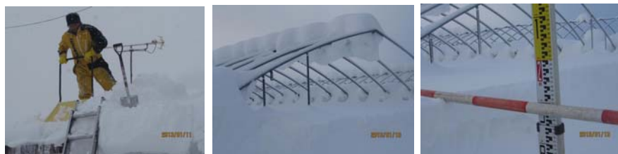
住宅の除雪(1月11日) ハウスの積雪状態の確認～1m90cmありました(1月13日)
