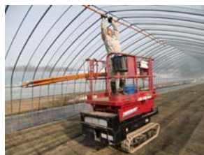
灌水パイプの取り付け(4月6日)
