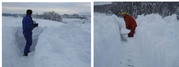
倉庫の屋根雪下ろし～屋根の尾根に沿つて切込みを入れる作業(1月18日)
