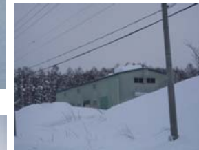
翌朝、屋根雪が落ちた倉庫(1月19日)
