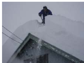
納屋の屋根雪下ろし作業(1月13日)
