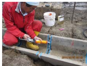
壊れたトラフの入れ替え(5月9日)
