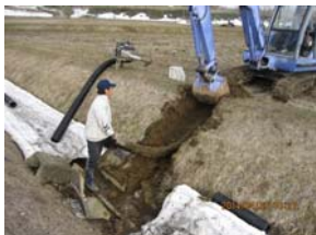
畦畔に落ち口樹を取り付ける作業(4月28日)
