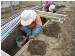
水路の補修作業(5月3日)
