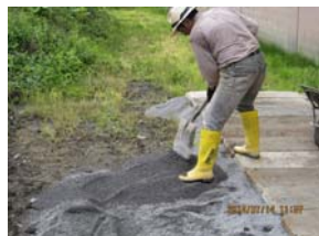
一輪車で砂を運び、丁寧に敷均した後にコンクリート版を敷きます(7月14日)
