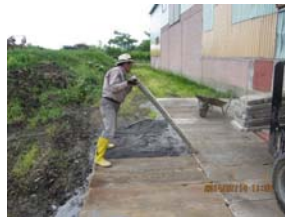
この場所は、秋になると乾燥機の排風ダストから出るゴミがたまる場所。機械でゴミをさらい易いように工夫しました(7月14日)
