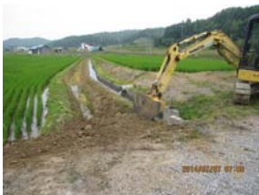
この水路を埋め直す
