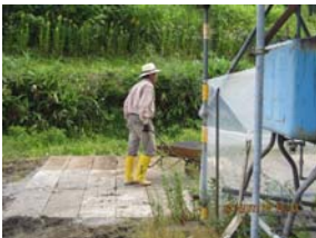
倉庫の裏側の整備
