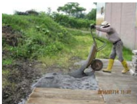
一輪車で砂を運び、丁寧に敷均した後にコンクリート版を敷きます(7月14日)
