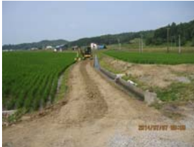
新たに農道が出来上がりました
