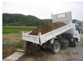
農道整備 使っていない水路を埋めて新たに農道を作る作業(7月7日)
