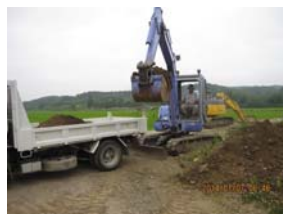
農道整備 使っていない水路を埋めて新たに農道を作る作業(7月7日)
