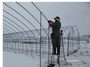
ハウスの組み立て作業(3月4日)
