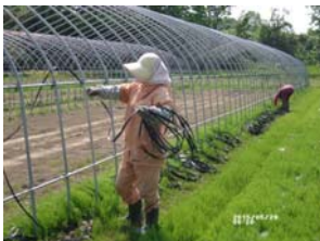
育苗ハウスの解体 (5月29日)
