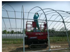
育苗ハウスの解体 (5月29日)
