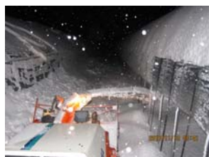
早速、除雪機で除雪作業開始(11月10日)
