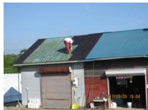
納屋の屋根の塗装下塗り(8月5日)
