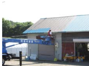
屋根塗装の仕上げ(8月7日)
