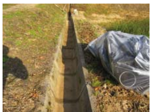
落水後は水路の補修も行います(9月14日)
