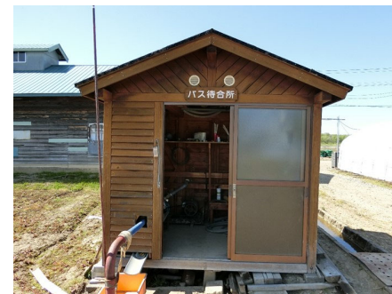
バス待合所を活用したポンプ小屋(5月19日)
